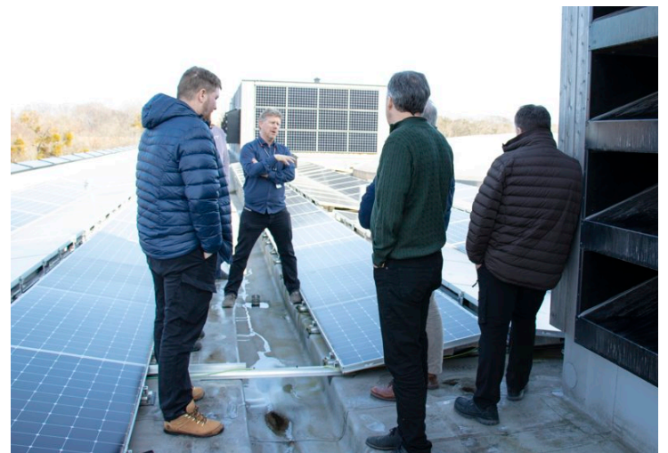
- Skolen bruker mindre energi enn beregnet - og solcellene på taket produserer mindre energi enn beregnet, sier rådgiver for eiendom i Vestfold og Telemark, Torbjørn Lunde.
